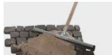
Einarbeiten mit Gummischieber
