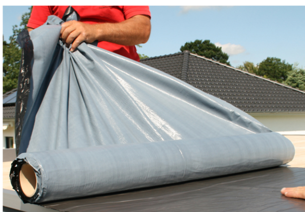
KSK-M Dachbahn beim verlegen
