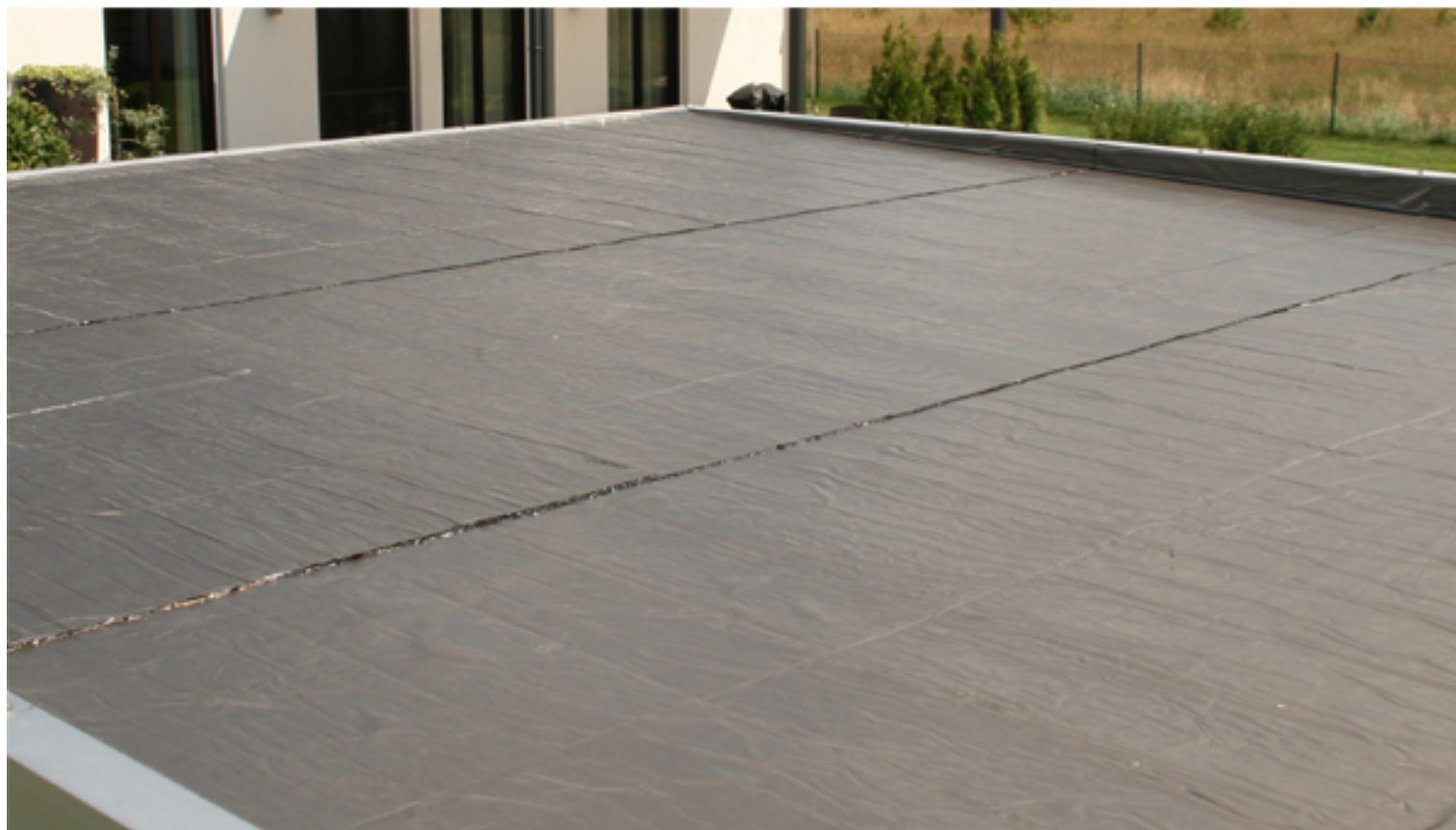
KSK-M Dachbahn verlegt
