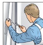
5. In Ecken und an Kanten wird nicht überlappend tapeziert, sondern die Trennung erfolgt exakt auf der Kante und nachfolgende Bahn auf Stoß tapezieren.
