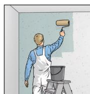
2a. Bahnen in erforderlicher Länge unter Zugabe von 5 - 10 cm zuschneiden. Kleister nach Herstellerangaben anrühren und Vlies-Tapete
