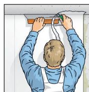
4. Überstände an Decken, Fußleisten, Fenster (gem. Online-Hilfe) usw. mit dem Cuttermesser und dem Tapezierspachtel abtrennen.
