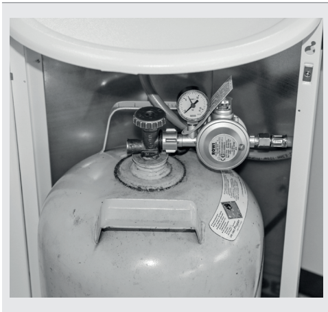
Abb.3: Installation der Gasflasche
